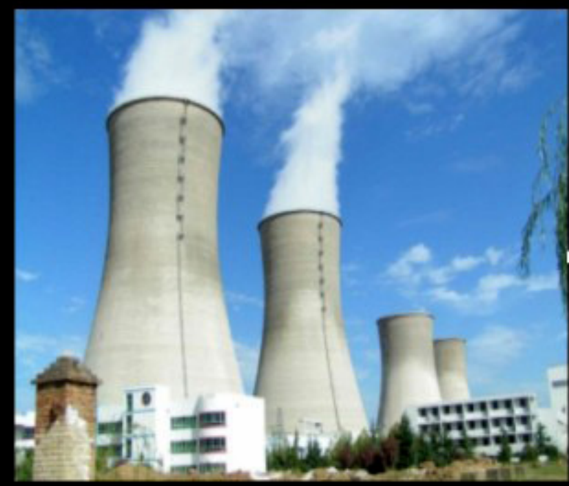
鍋爐（廢氣廢熱）
